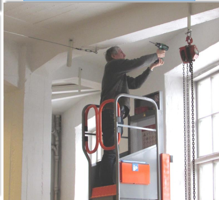
Borrning för nya fästen i taket för material som ska fästas upp i takbjälken.
